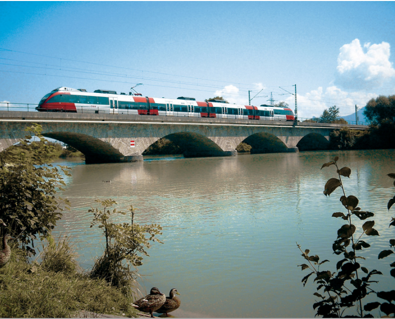
Blick auf die bestehende Eisenbahnbrücke über die Saalach Foto: Martin Kolenig
