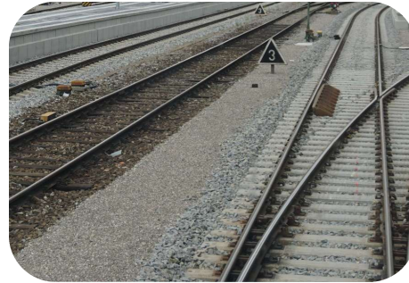
115 km neue Gleise
