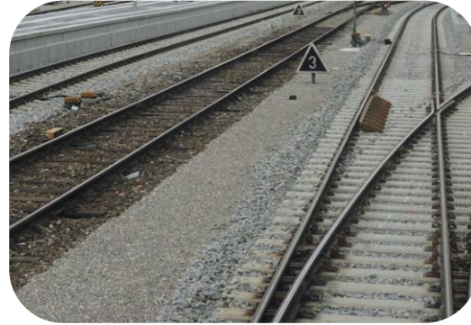
115 km neue Gleise
