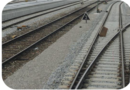
3 km neue Gleise
