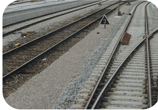
115 km neue Gleise
